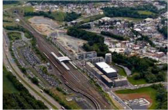
ICE-Bahnhof mit Gewerbepark und FOC-Baustelle. Quelle: www.montabaur.de
