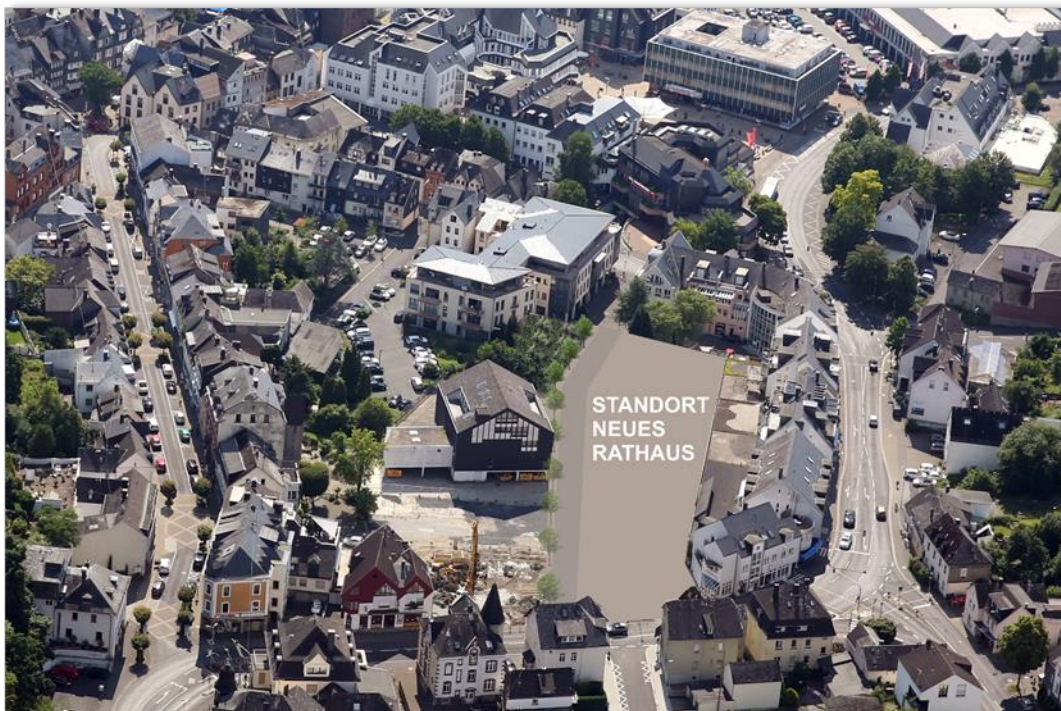
Abbildung 36: Standort des neuen Verbandsgemeindehauses (Quelle: Verbandsgemeinde Montabaur)
