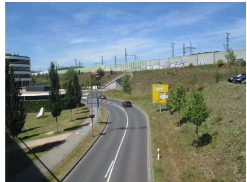
Blick von der Fußgängerbrücke auf die östlich des MTSO verlaufende Staudter Straße, welche an einem Kreisverkehr in die Bahnallee mündet. Die Tunneleinfahrt in der Bildmitte führt unter der ICE-Trasse zur Anschlussstelle der Autobahn A3
