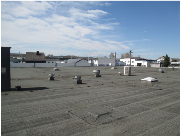
Dach, Blickrichtung Nordwesten
