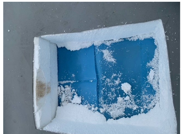
durch auftraggeberseitig bestellten Dachdecker geöffneter Dachaufbau
