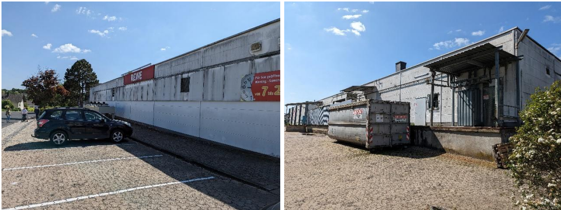
Abbildung 1: Links – Blick auf die östliche Gebäudeseite des REWE-Marktes mit vorgelagertes Parkflächen. Rechts – Blick auf die südliche Gebäudeseite mit Anlieferungs- und Entsorgungszone.
