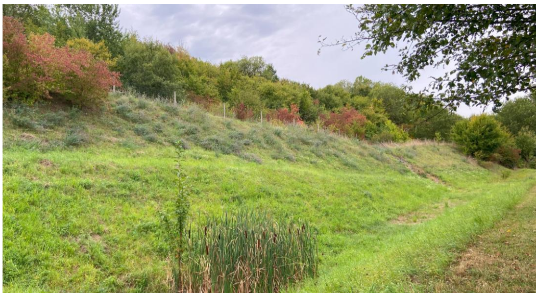
Abb. 2: Böschung / Regenrückhaltebecken zw. Autobahn und Plangebiet 1
