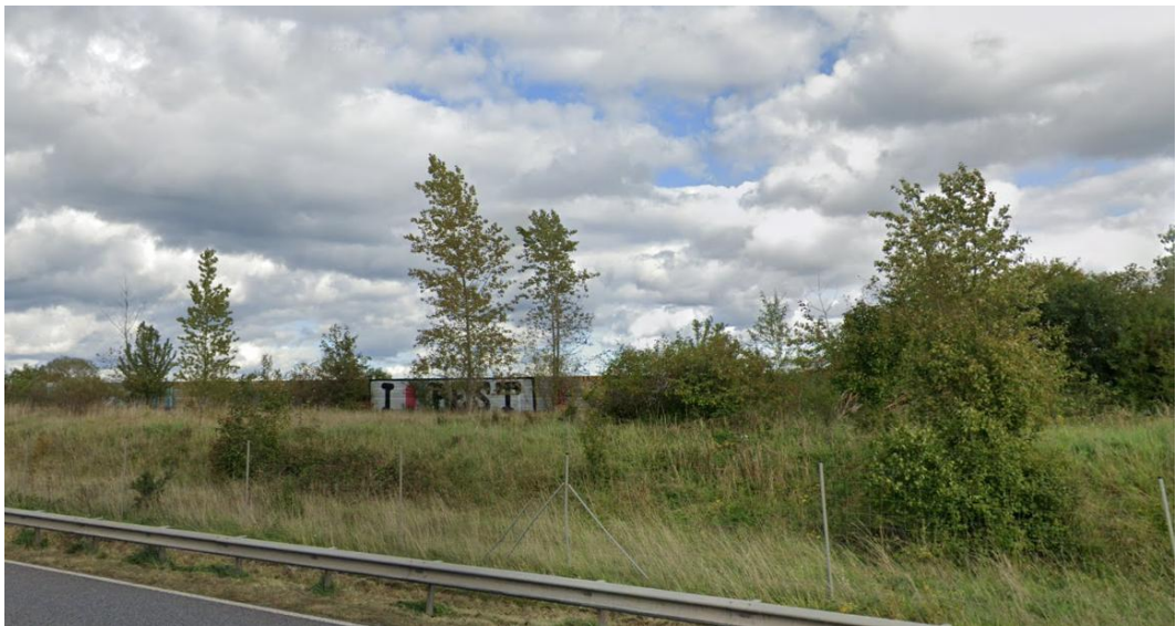
Abb. 8: Blick von der Autobahn A 3 in Richtung Lärmschutzwand bzw. Plangebiet 1
