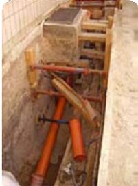
Bei stark geschädigten Leitungen bis zum Rohrbruch ist eine Erneuerung der Leitung erforderlich, die meist in offener Bauweise ausgeführt wird.
