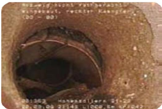
Durch undichte Abwasserleitungen kann Abwasser ins Erdreich einsickern und das Grundwasser verunreinigen.
