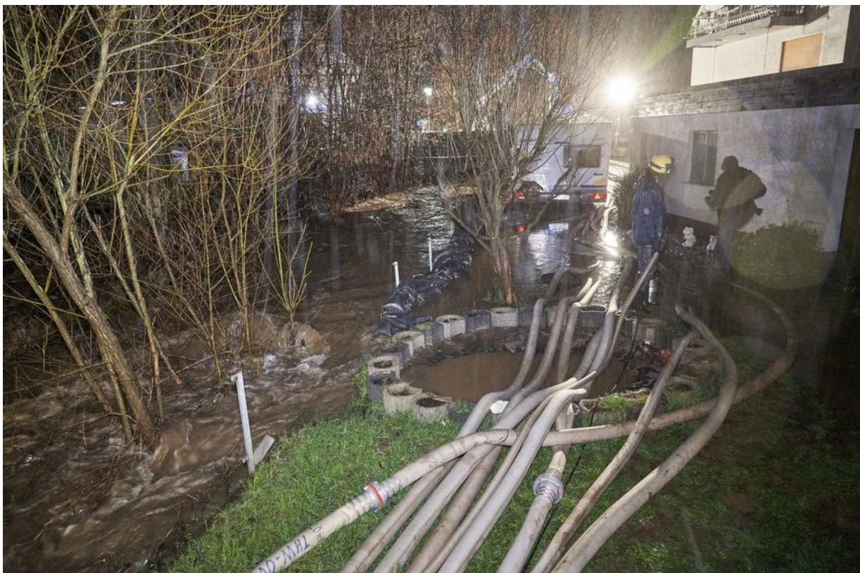
Abbildung 1: Vorsorgliche Maßnahmen zur Entschärfung des Brückendurchlasses „Hollerer Straße“ in der Vorflut und Nachflut (Sascha Ditscher, 2019)
